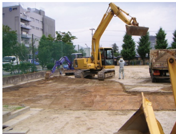
重機を用いた校庭の除染。グラウンド整備用の鉄トンボで十分だったのだが…。
