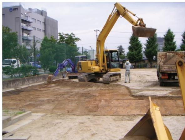
重機を用いた校庭の除染。グラウンド整備用の鉄トンボで十分だったのだが…。
