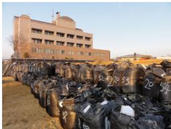
伊達市は、仮置き場の安全性を住民に訴えるため、梁川地区庁舎の駐車場に仮置き場を作った。
